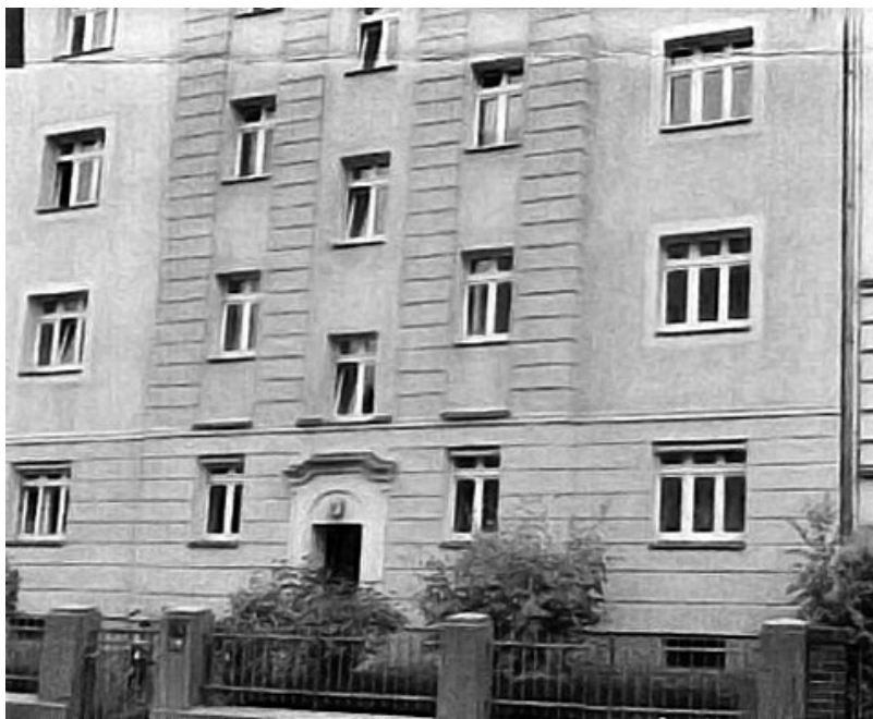
Dom przy Lindenstrasse 10 w Köpenick - taki adres podano w akcie zgonu pierworodnego syna. (fot. z Google, lipiec 2008)
