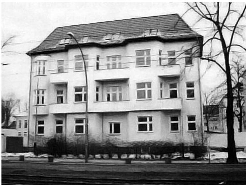
Dom przy Treskowallee 107 (po remoncie w 2006 r., fot. D. Klimm).
